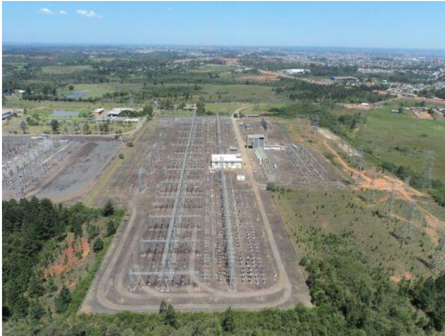
FIGURA 1 – Foto Aérea da Subestação Gravataí 2
