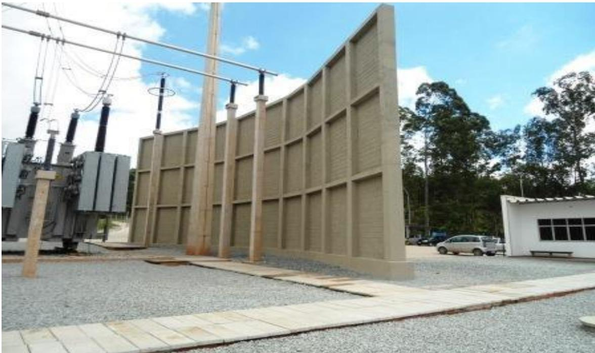
FIGURA 3 - Instalação de absorvedores de ruído
