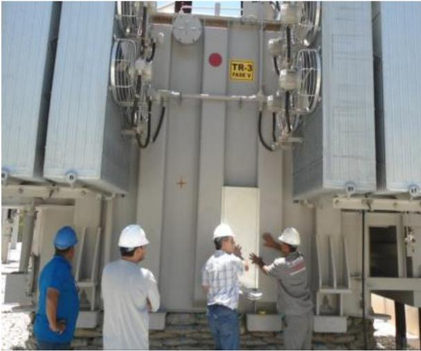
FIGURA 4 - Instalação de absorvedores de ruído
