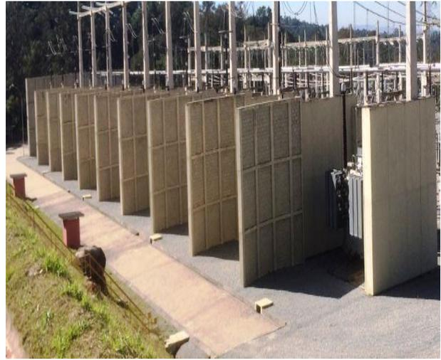
FIGURA 5 - Extensão das paredes corta fogo
