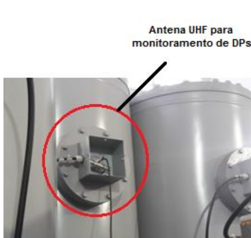
FIGURA 4 – Antena UHF interna já instalada na SIG
