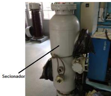
FIGURA 6 – Compartimento do seccionador a \text{SF}_6
