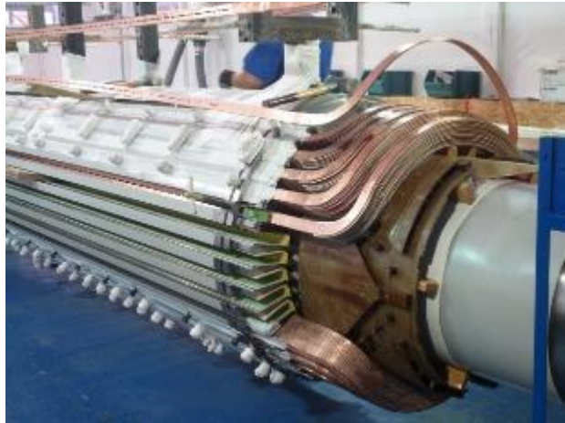
Figura 8 – Rebobinagem do rotor
