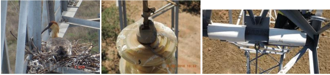
FIGURA 5 – Curicaca e respectivo ninho, marcas de curtos-circuitos nos isoladores e dispositivos anti-curicacas
