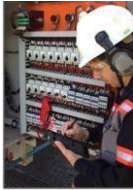
FIGURA 6 – Técnico inspecionando painel com apoio do tablet
