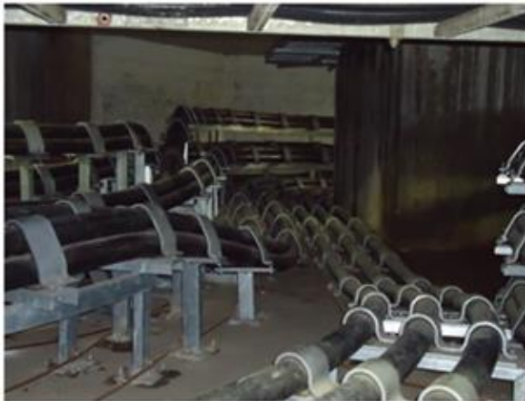
Figura 9: Passagem dos cabos de linha
