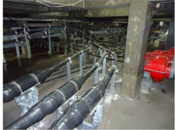
Figura 12: Vista parcial do porão velho
