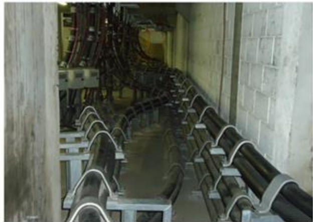
Figura 10: Passagem dos cabos dos transformadores
