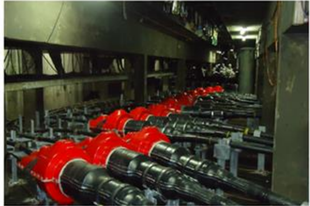
Figura 8: Detalhe das emendas de transição
