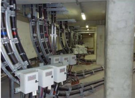
Figura 7: Detalhe dos tobogãs no porão novo
