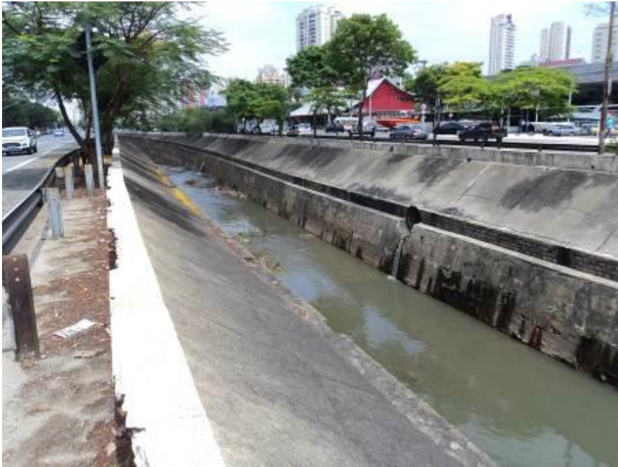
Figura 7 : Trecho com travessia do Rio Ipiranga
