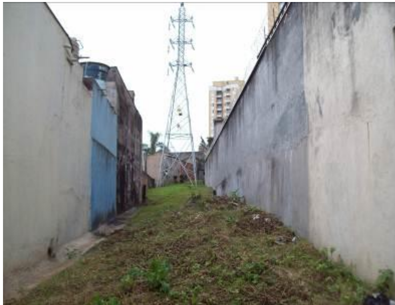
Figura 5: Trecho de faixa de servidão enclausurada
