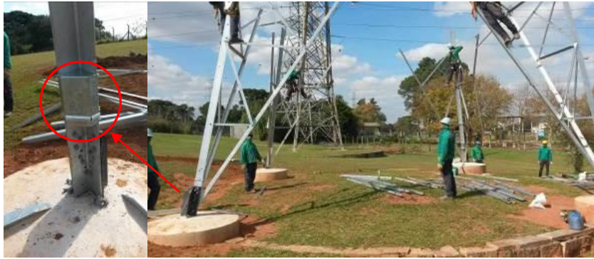
FIGURA 2 – Montagem das ferragens dos pés da torre, incluindo as peças instrumentadas.
