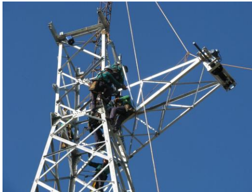
FIGURA 3 – Fixação da mísula com um dos sistemas de tracionamento de cabos na torre.
