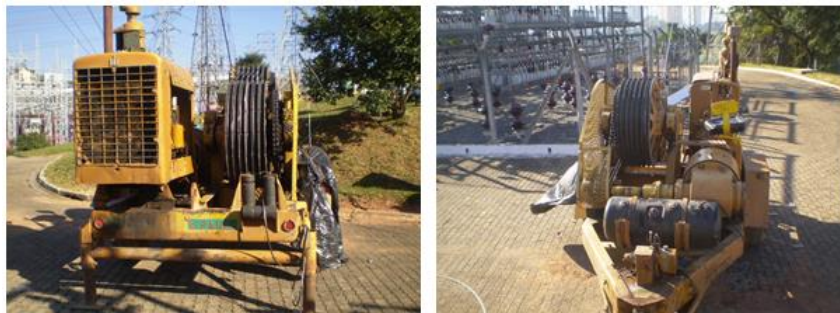
FIGURA 13 – Equipamentos de Lançamento de Cabos em Áreas Energizadas
