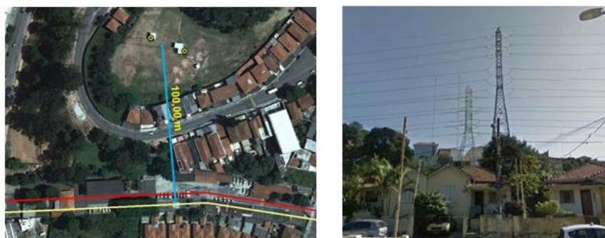
FIGURA 15 – Vista das Antenas de Rádio AM (planta e visão da rua próxima)
