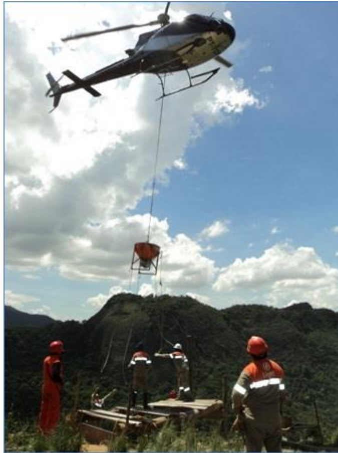
FIGURA 5 – Transporte de concreto por helicóptero
