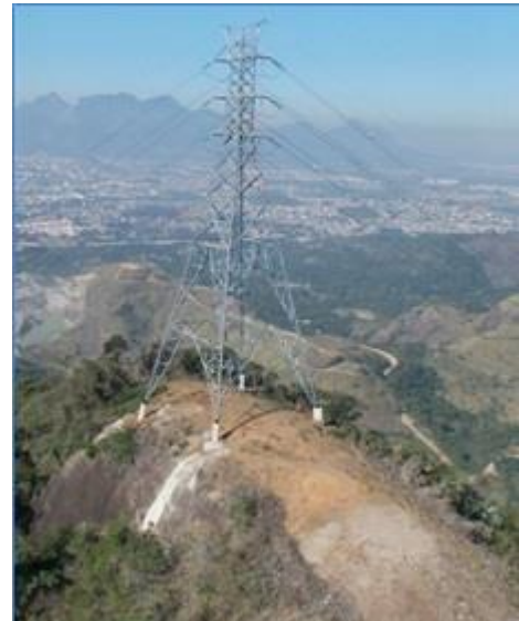
FIGURA 7 – Torre T.3 da LI-CUR-JP 1 e 2
