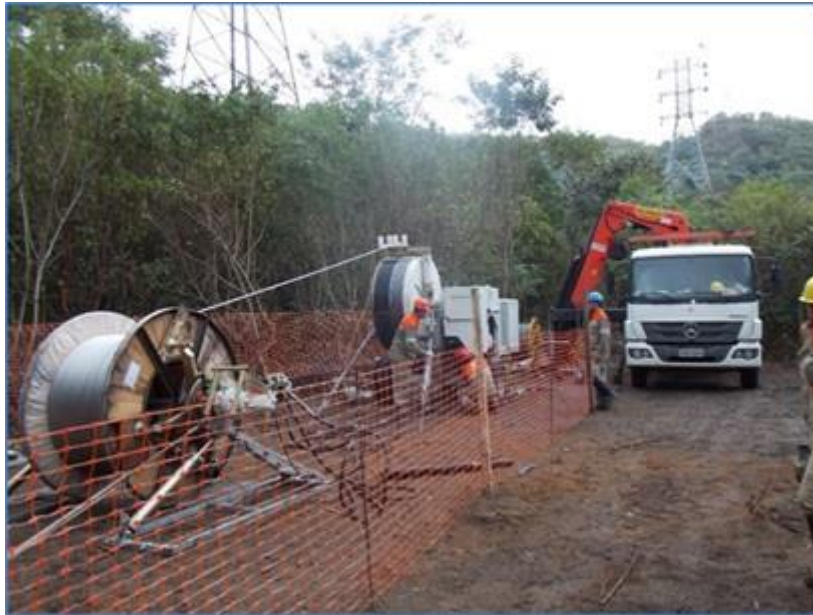
FIGURA 8 – Praça de lançamento de cabos com puller instalado
