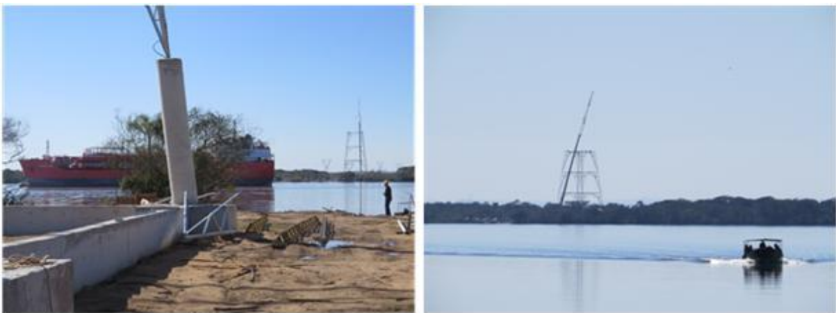
FIGURA 8 - Fotos da reconstrução das torres de travessia
