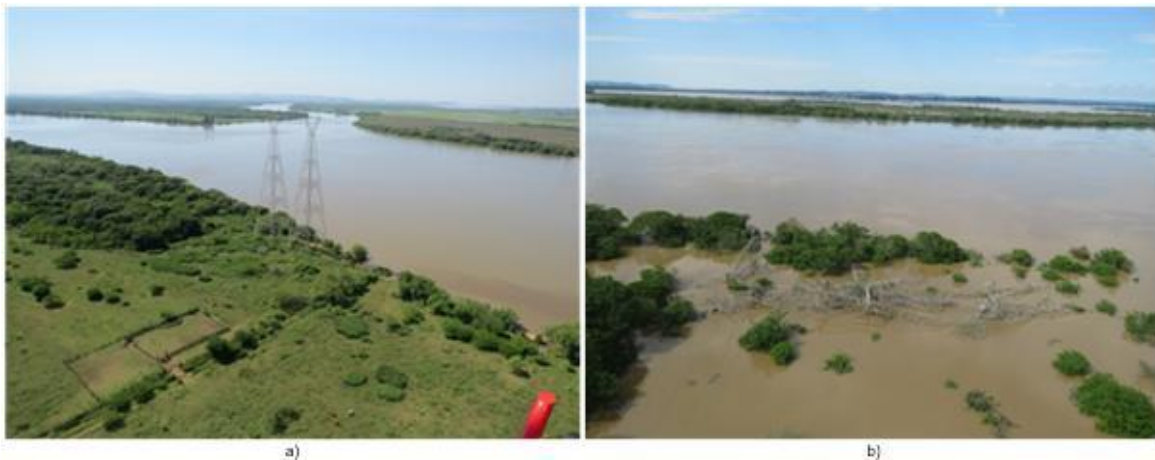
FIGURA 5 - Travessia do Rio Jacuí: a) torres ETB antes do acidente e b) imagem das mesmas torres em sobrevoo após o acidente
