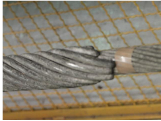
FIGURA 10 - Sem evidências de escorregamento da emenda.
