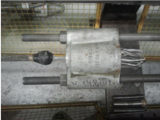
FIGURA 5 – Detalhe da ruptura da coroa de alumínio do cabo junto ao ponto de ancoragem.
