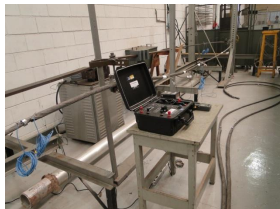
FIGURA 12 – Executando medições com miliohmímetro.
