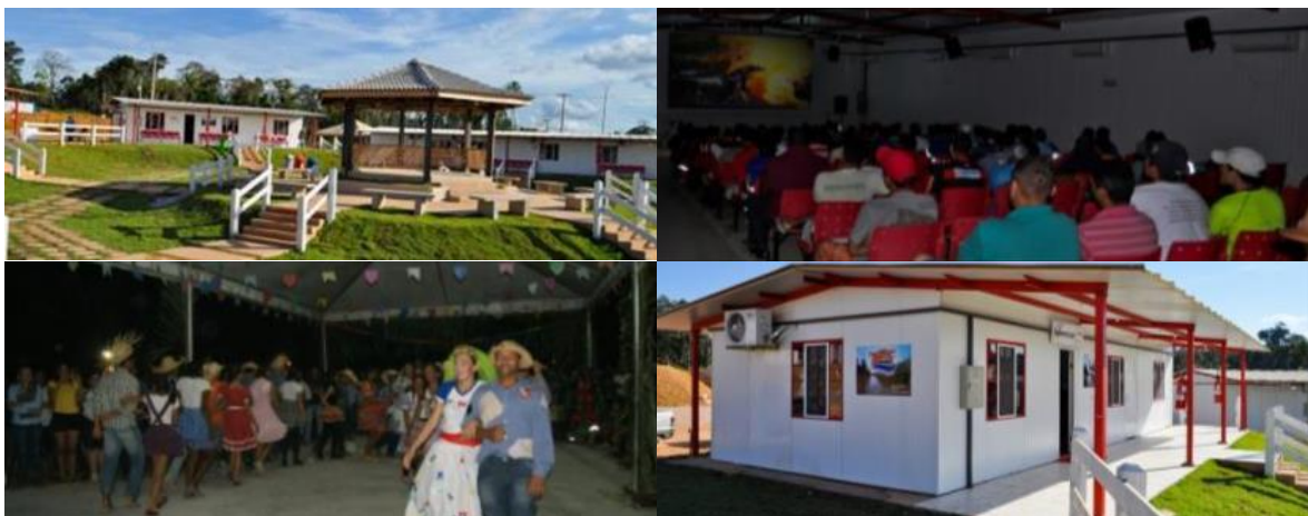
Figura 4. Registro fotográfico do canteiro de obras – área de lazer, cinema, festividade e mini-mercado.
