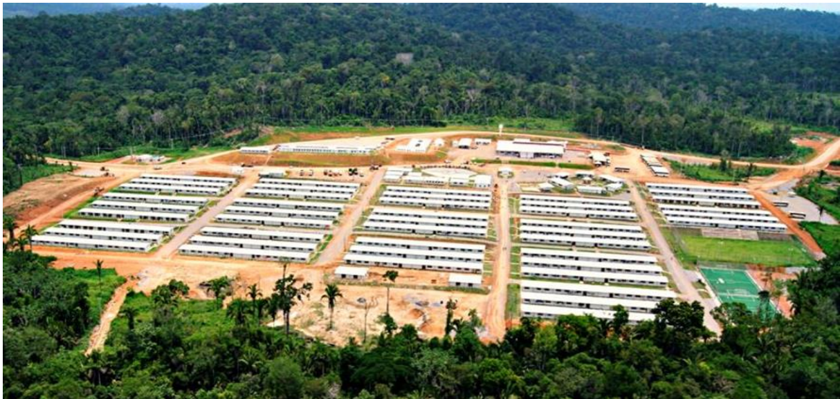
Figura 3. Registro fotográfico do canteiro de obras – alojamentos, área de lazer e refeitório.
