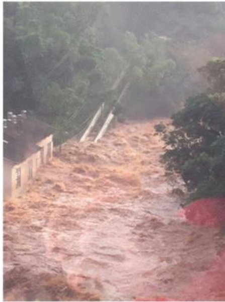
Figura 03 – Inundação PCH Apucarantina (10 MW).
