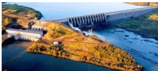
FIGURA 5 – Foto da UHE Salto Caxias (UHE GJR).
