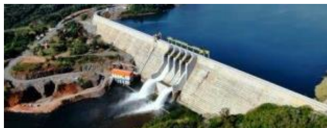
FIGURA 8 – Foto da barragem da UHE Mauá (UHE GJC).
