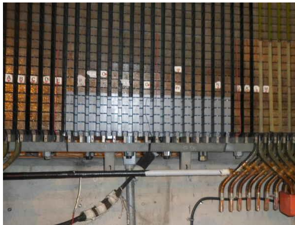
FIGURA 7 – Núcleo sendo montado e finalizado com novo bloco de lâminas
