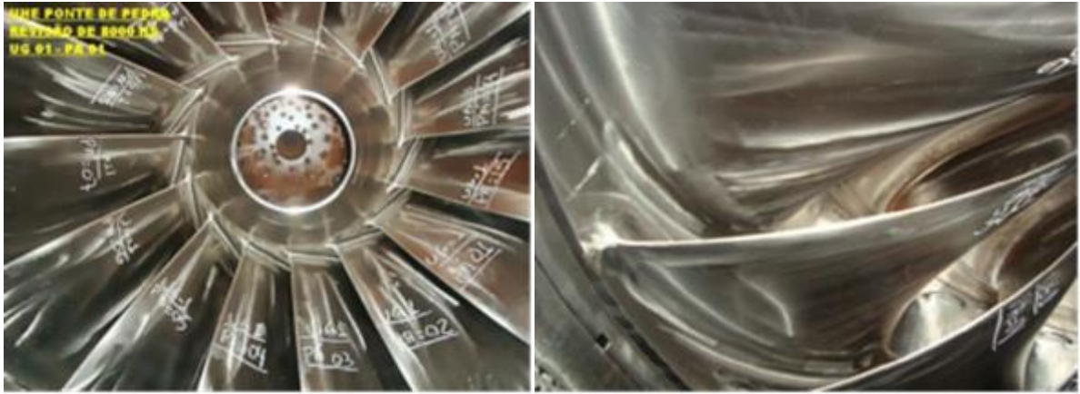
Figura 1 - Rotor da unidade 1 da Usina Hidrelétrica de Ponte de Pedra durante a inspeção de 8000 h [3].
